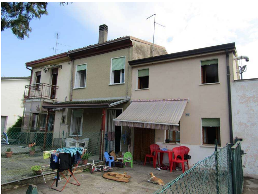
Foto 5: vista d'insieme del fabbricato confinante a nord
