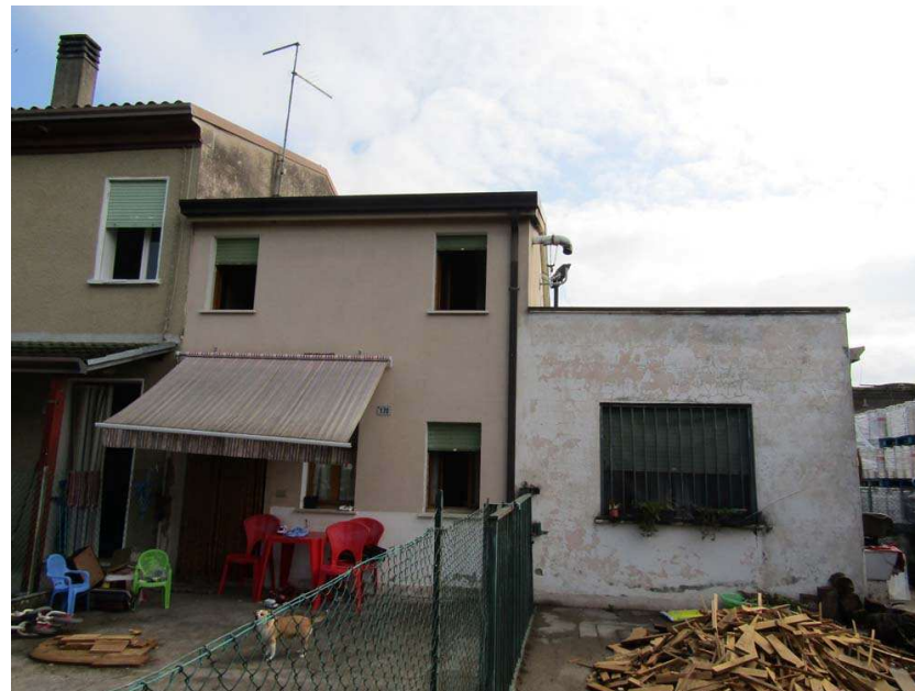
Foto 6: vista del prospetto principale sud
