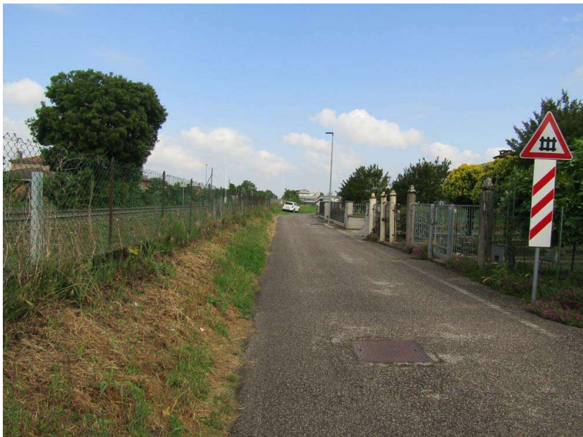
Foto 1: vista d'insieme di Via Alfieri verso nord
