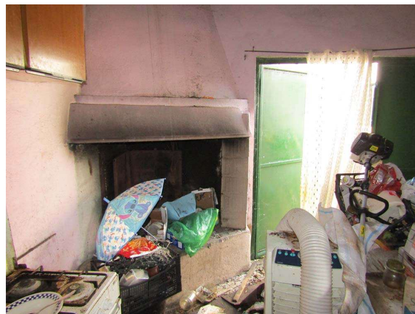
Foto 24: altra vista del ripostiglio esterno
